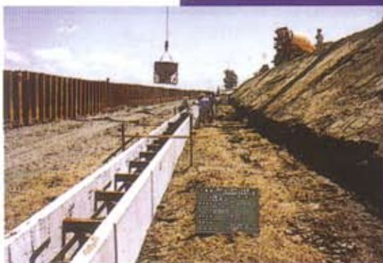
中詰コンクリート打設
